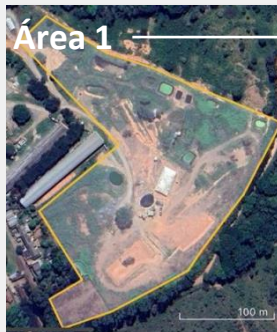
Planta de Biogás
