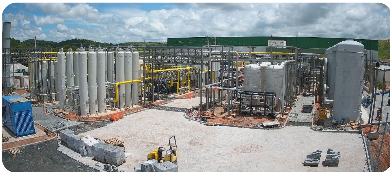
Foto: Canteiro de obra da implantação do projeto de biometano em Jaboatão dos Guararapes em março de 2025.
