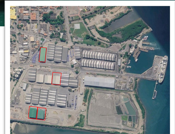
Galpões operados pela Transcopa no Porto de São Sebastião-SP
