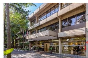
VERBO DIVINO ✓ Edifício Classe A São Paulo / 1985 8.386 m 2 (66,57% SYN)
