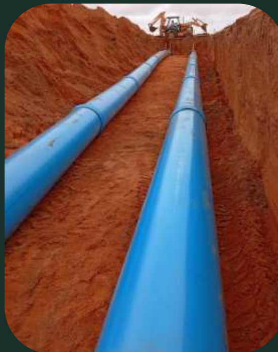
Instalação Adutoras 500mm
