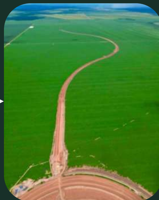
Canal conectando c/ reservatório em construção
