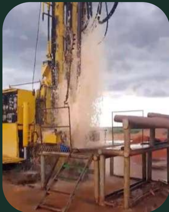
Perfuração poços 300m 3
