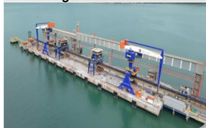
2 novos guindastes instalados
