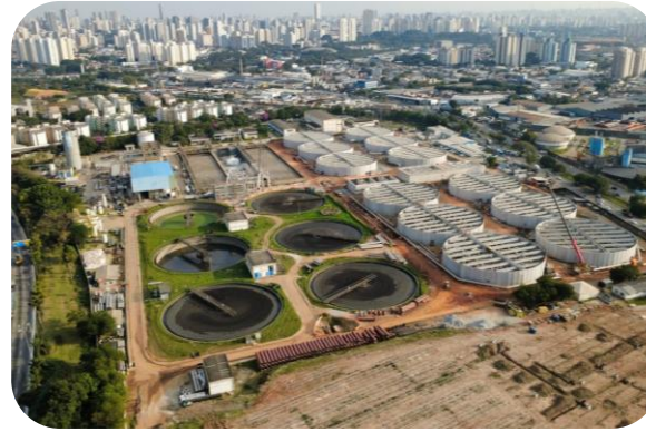
WWTP Parque Novo Mundo
