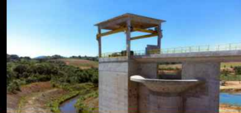
SAA SJP – Barragem Miringuava Vertedouro Tulipa
