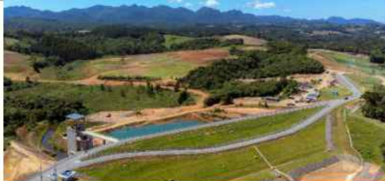
SAA SJP – Maciço Barragem Miringuava
