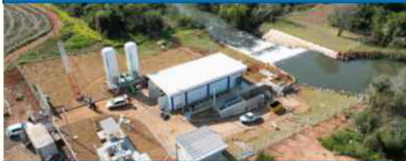
SAA Cianorte - Captação
