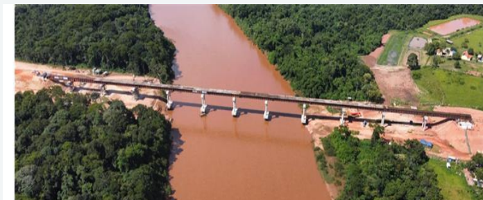
Ponte sobre o Rio Vermelho a 35 km de Rondonópolis
