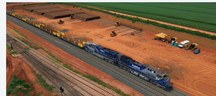
Chegada trilhos para armazenagem em Mato Grosso
