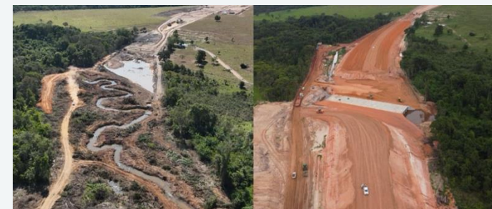
Trabalho de terraplanagem em trechos críticos (km 56)
