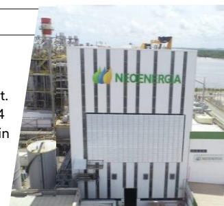
PHOTO: TPP Termopernambuco - PE
