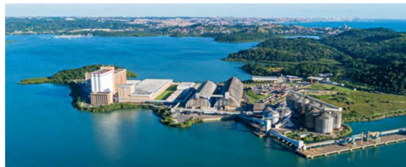
Unidade Salvador (BA) localizada ao lado do Porto Cotegipe
