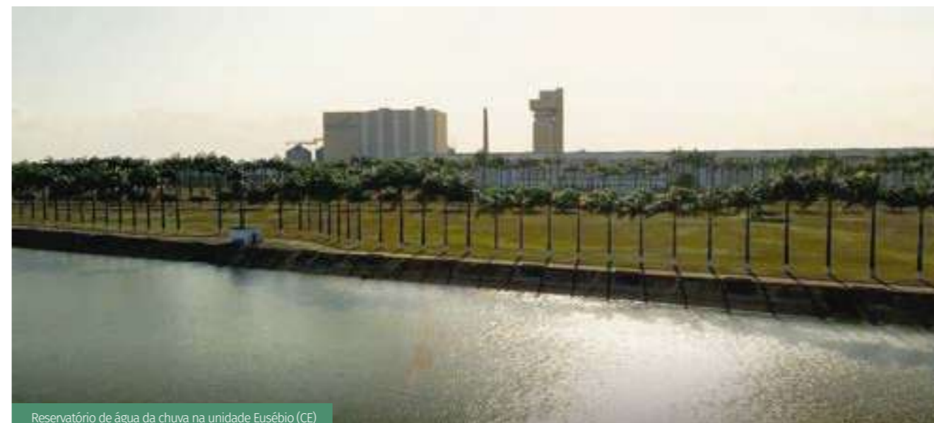
Reservatório de água da chuva na unidade Eusébio (CE)
