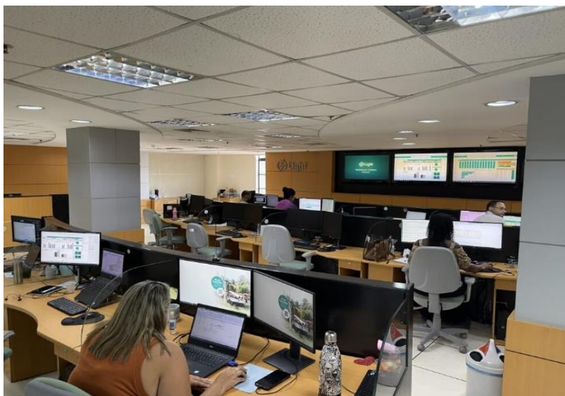
Figura 3 - Centro de Controle
