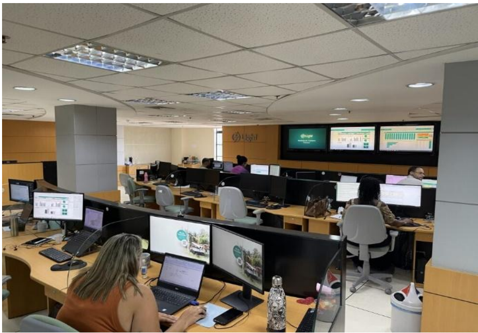
Figura 3 - Centro de Controle
