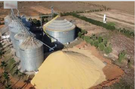
Colapso na Infraestrutura
