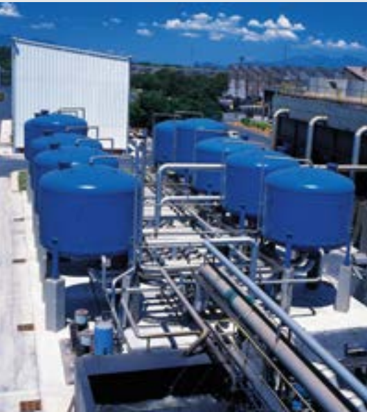
Sistema de recirculação e tratamento de água na Unidade Cosigua (RJ)
