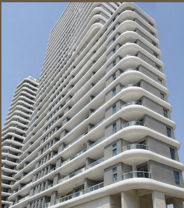
Fachada Torre Shanghai e Paris
