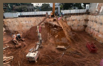
Escavação e tirantes
