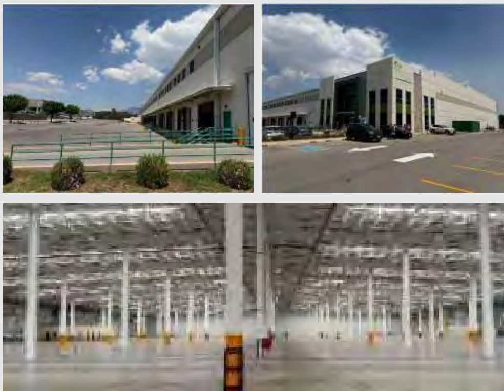
Novo Centro de Distribuição da Dacomsa Estado do México
