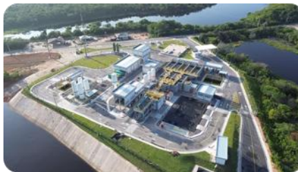
Captação: Vista aérea geral
