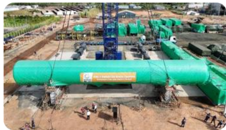
Descarregamento dos equipamentos nas bases
