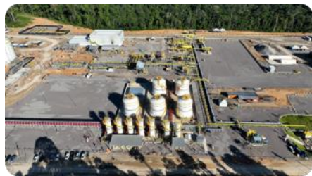
UTG: Vista aérea geral
