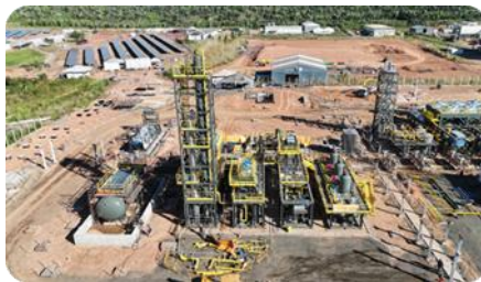
Montagem de equipamentos
