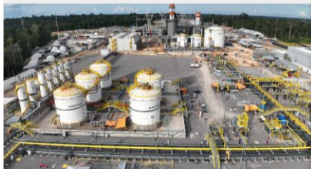
UTG: Vista Aérea geral
