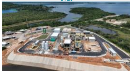
Captação: Vista Aérea geral
