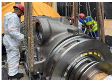
UTE AZU II: Posicionamento do Inner Casing ST20
