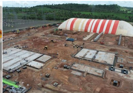
Obras civis – Fase 1
