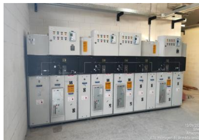
Captação: Início da montagem dos painéis elétricos na subestação
