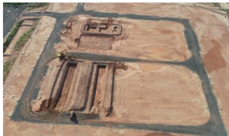
Início das Obras Civis
