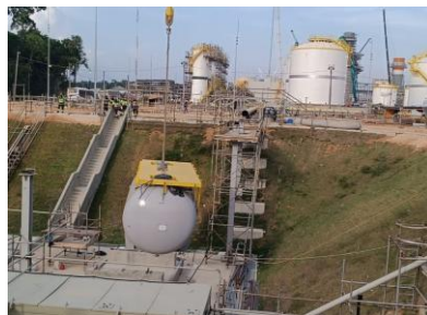
UTG: Montagem do vaso de knockout
