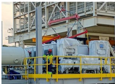
UTE: Posicionamento do disjuntor principal (GCB da GT11)
