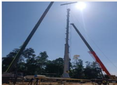
Montagem do Flare e das EMEDs sobre as bases
