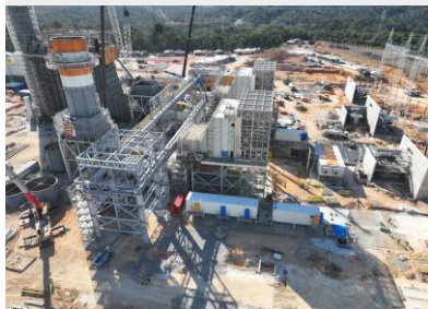
Recebimento e início da montagem dos pipe racks de manutenção e modularizado
