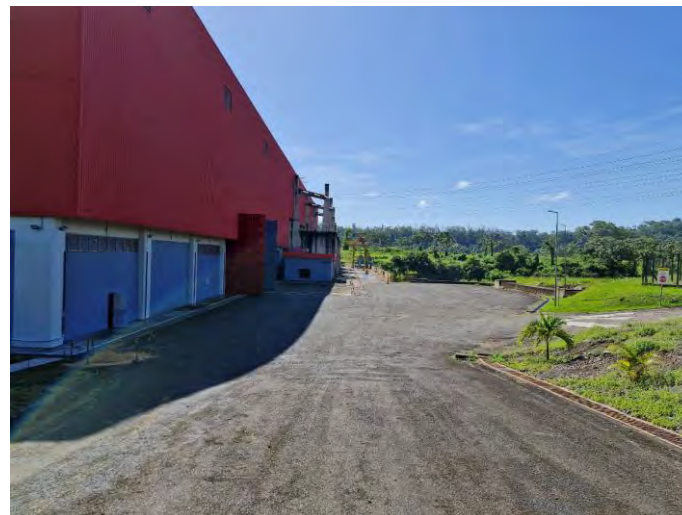
Foto 8 – Casa de Força principal
