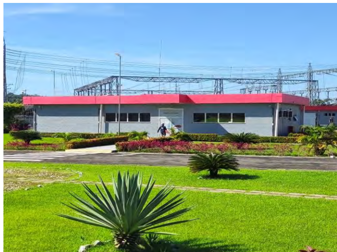
Foto 10 – Edifício controle (Escritório)
