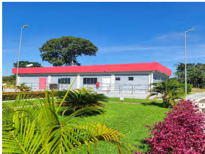
Foto 11 – Refeitório e Auditório
