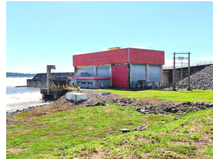
Foto 9 – Casa de Força auxiliar
