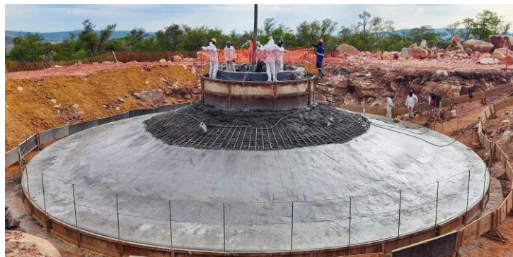
Concretagem das fundações
