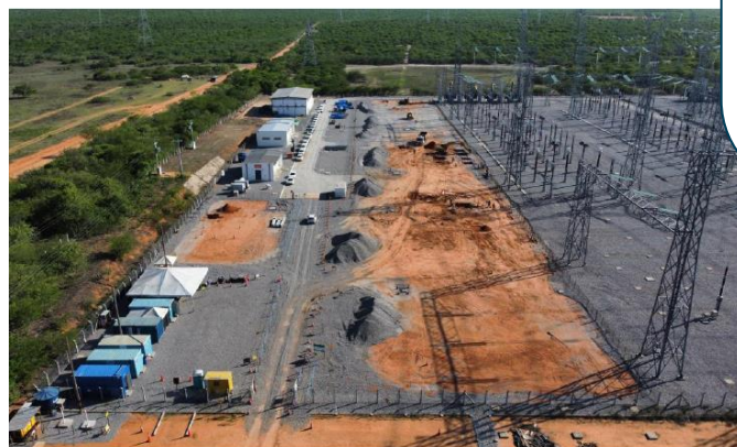
Obras bay de conexão
