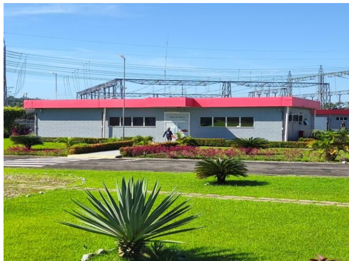
Foto 10 – Edifício controle (Escritório)
