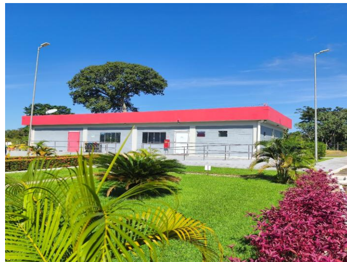
Foto 11 – Refeitório e Auditório
