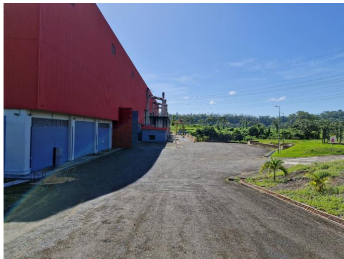
Foto 8 – Casa de Força principal
