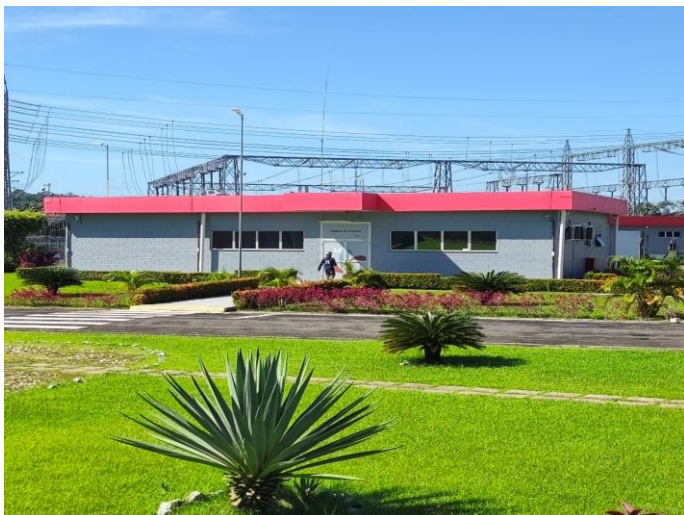
Foto 10 – Edifício controle (Escritório)
