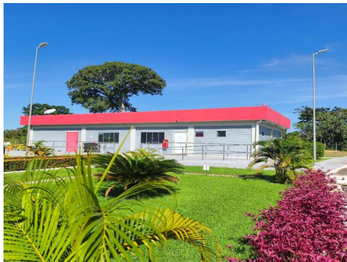
Foto 11 – Refeitório e Auditório
