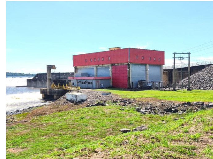
Foto 9 – Casa de Força auxiliar
