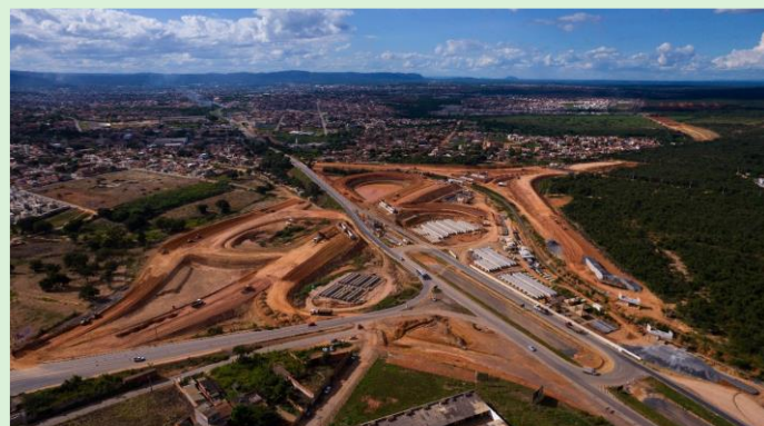
Eco135 - Obras de implantação do Anel Viário de Montes Claros
