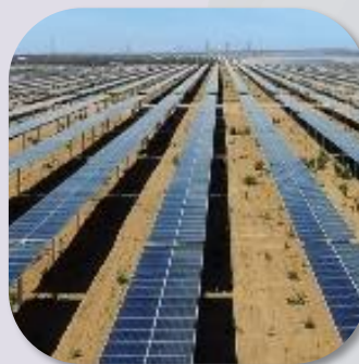
Tubos estruturais para energia fotovoltaica
