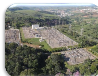
SE Lafaiete Novos equipamentos
