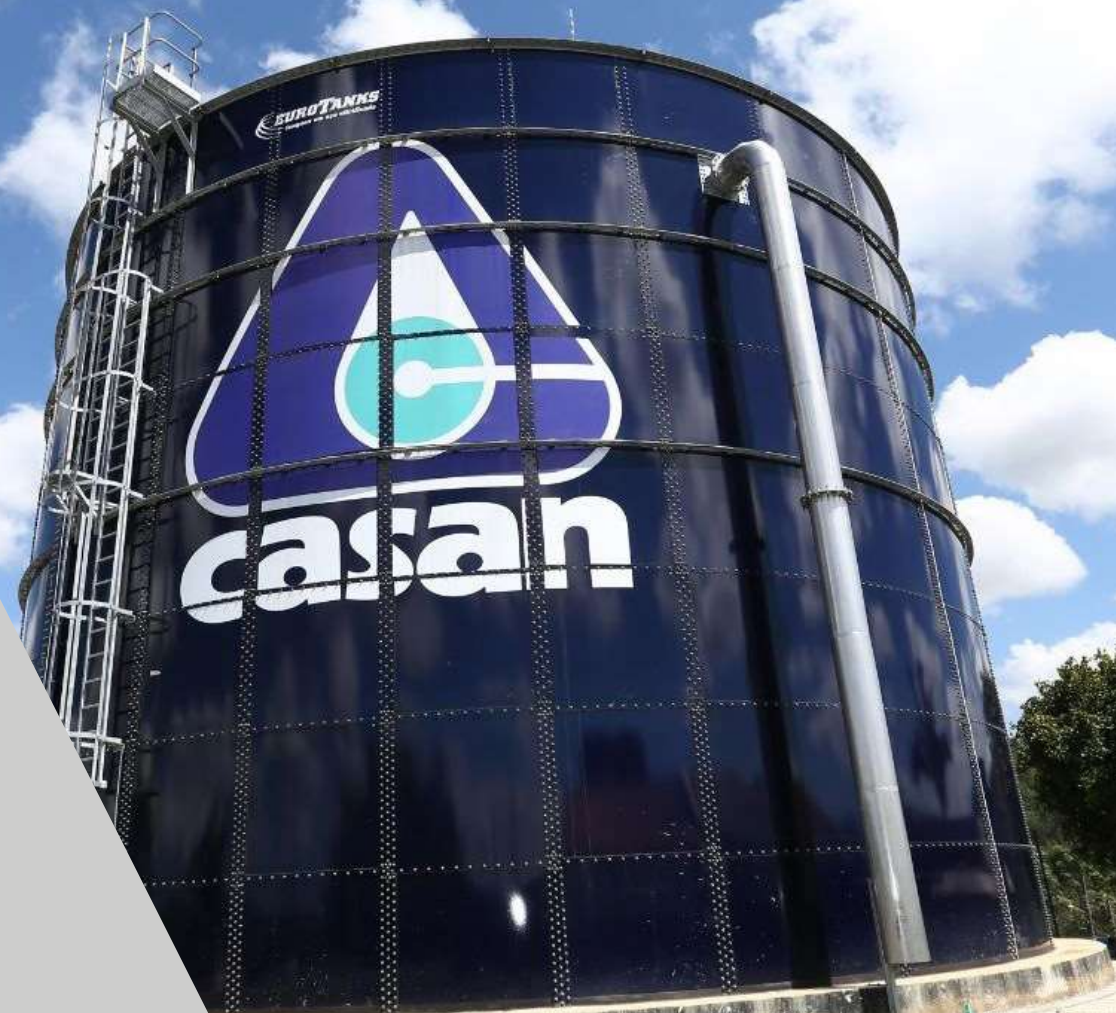
Reservatório de aço vitrificado em Canoinhas
