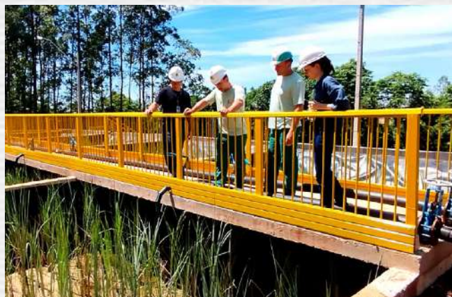
Wetland construído para o tratamento do percolato
