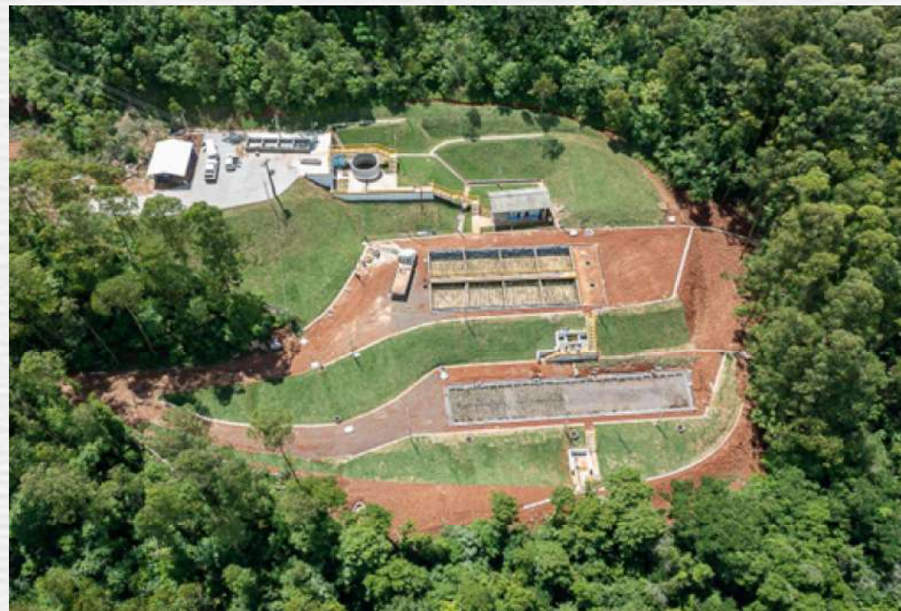
Vista geral da Unidade de Gerenciamento de Lodo em Descanso/SC
