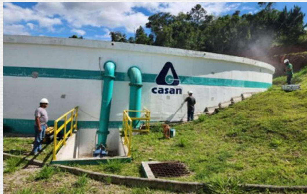
Figura 2 - Extração de corpos de prova do Reservatório Forquilha 2 para análise estrutural.
