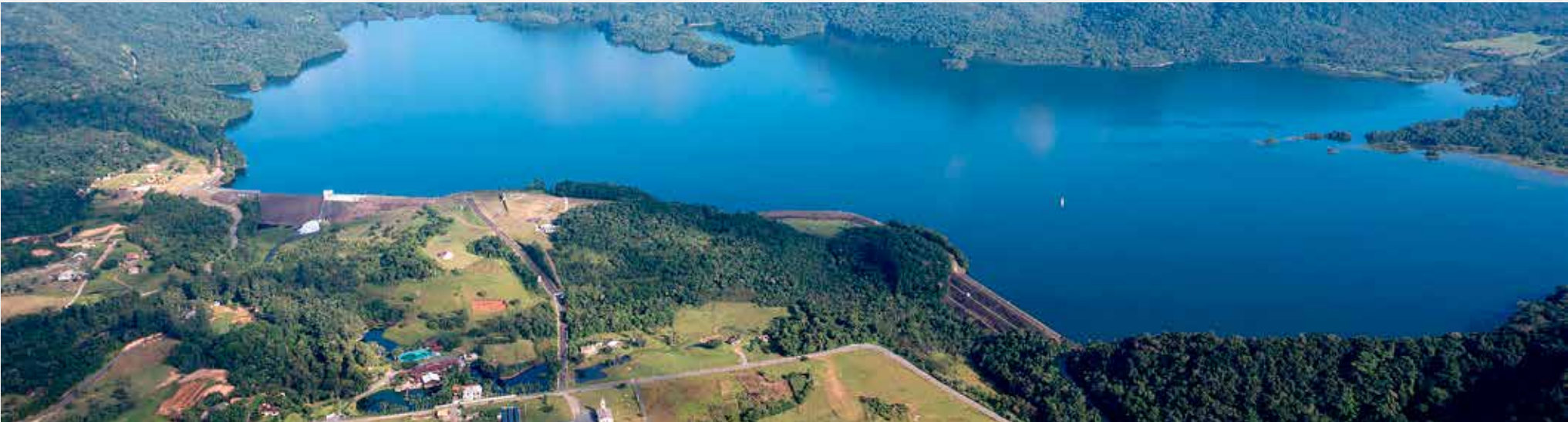
Barragem São Bento
