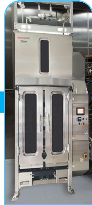
Reator de 3.000 litros para produção dos IFAs dos Anticorpos Monoclonais no P400.
