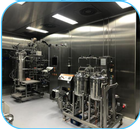
Reatores para cultivo celular e fermentação de bactérias no P400.
