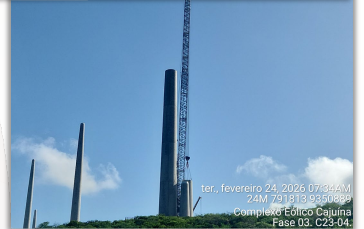
Montagem de Tramos
