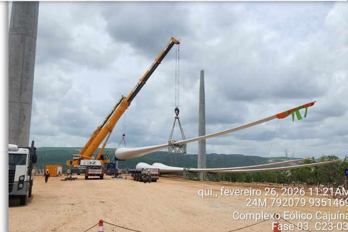
Descarregamento de Blades
