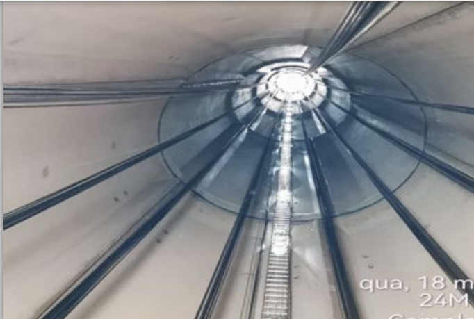
Atividade de tensionamento de cabo
